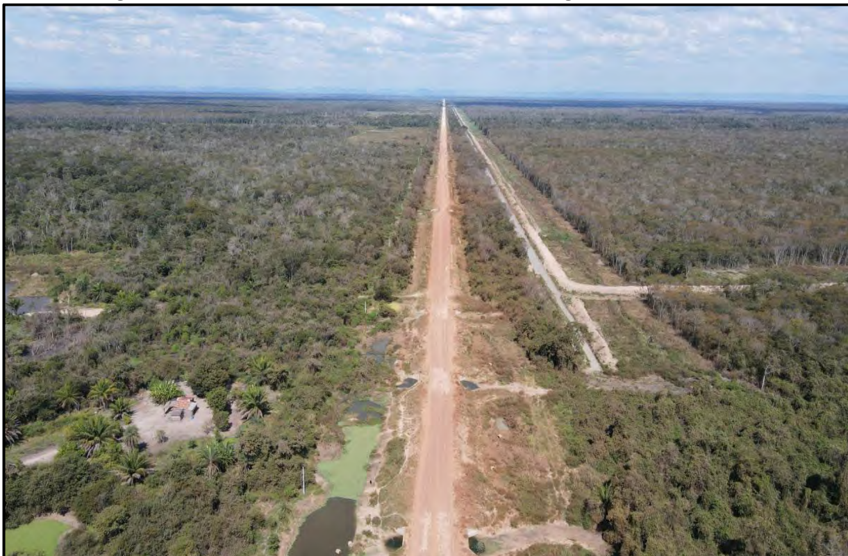
Fotografía # 5: San Antonio-Plataforma causante de la anegación en la comunidad
