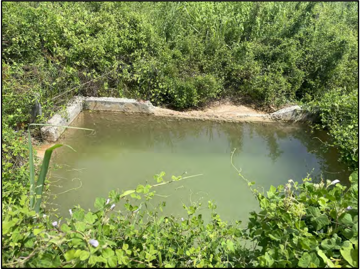
Fotografía # 10: Mira Flores-Rebalse de químicos terminan en la represa
