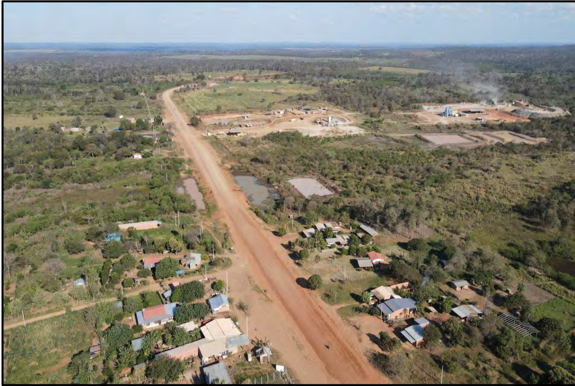
Fotografía # 8: Mira Flores-Vista general del campamento y la represa
